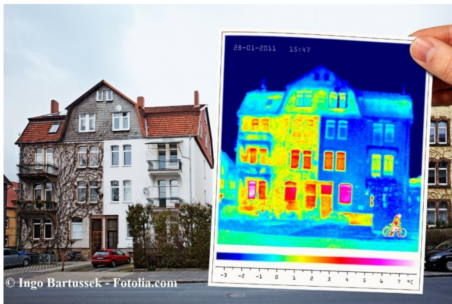
Abbildung 108. Wärmebild eines Wohnhauses: Visualisierung von Energieverlusten
